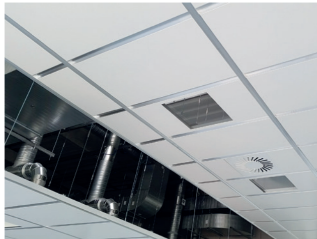
Detail der Paneelaufhängung
